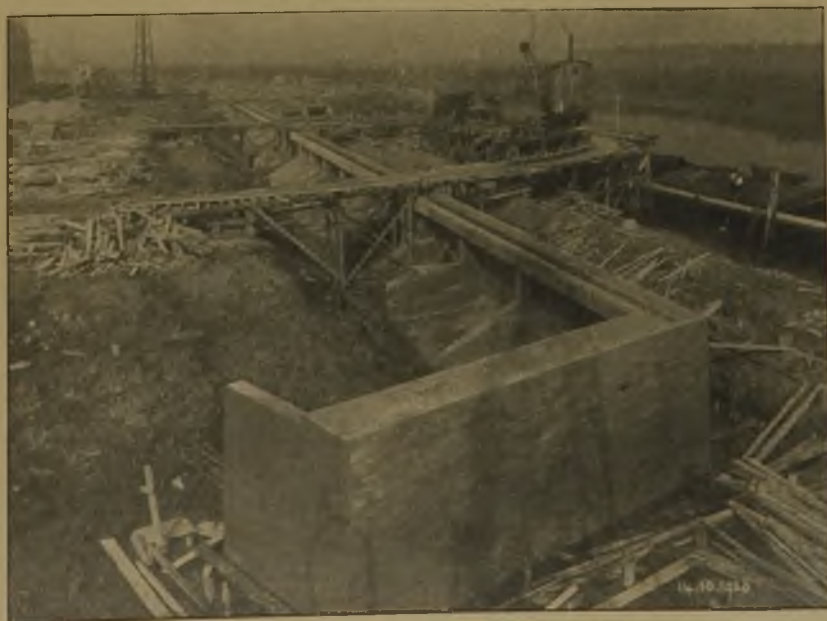
Abb. 7. Kaimauer längs der Werfthalle.
