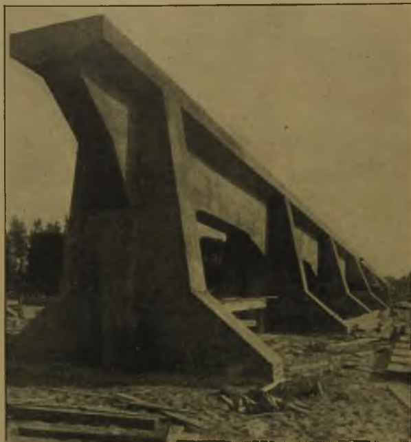
Abb. 2. Eisenbeton-Schiffshelling. Schiffbau-Werft van Driel, Papenrecht.
