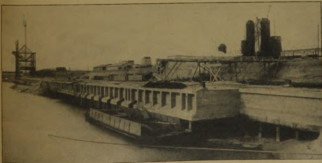
Abb. 12. Eisenbeton-Kaimauer der Königlich-Niederl. Hochofen- und Stahlfabriken, Ymuiden.
