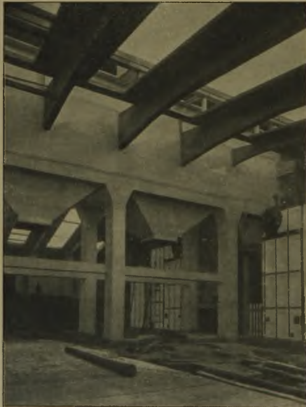
Abb. 6. Blick in das Kesselhaus.
