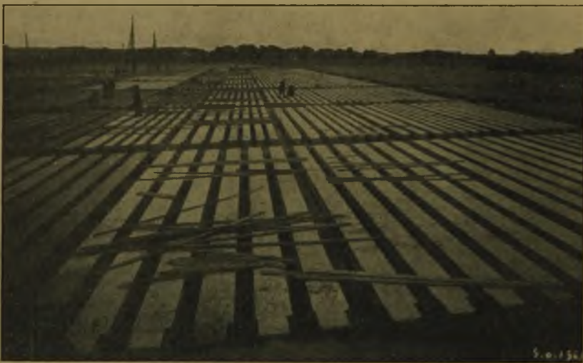
Abb. 14. Spundwandlager für die Kaimauer in Ymuiden.
