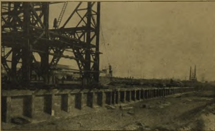
Abb. 15. Ansicht der fertigen Kaimauer in Ymuiden.
