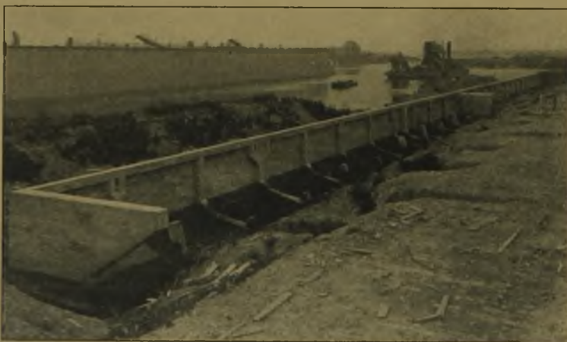
Abb. 9. Kaimauer Wilton-Werft vor Hinterfüllung. Werft- und Wasserbauten in Holland.
