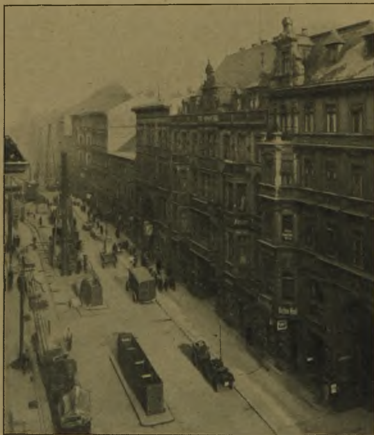
Abb. 7. Straßenbild über der Tunnelbaugrube.
