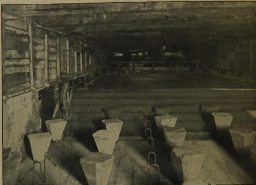
Abb. 10. Aufbringung der Betonsohle des Tunnels.
