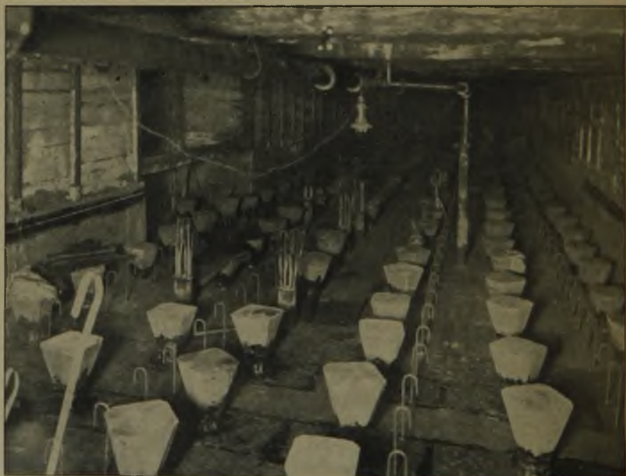
Abb. 9. Tunnelstrecke mit fertig abgesenkten Pfählen (Pfahlköpfe noch nicht einbetoniert).
