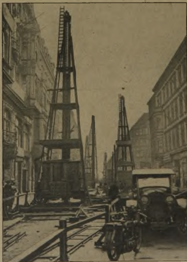
Abb. 8. Rammarbeiten in der Friedrich-Straße.
