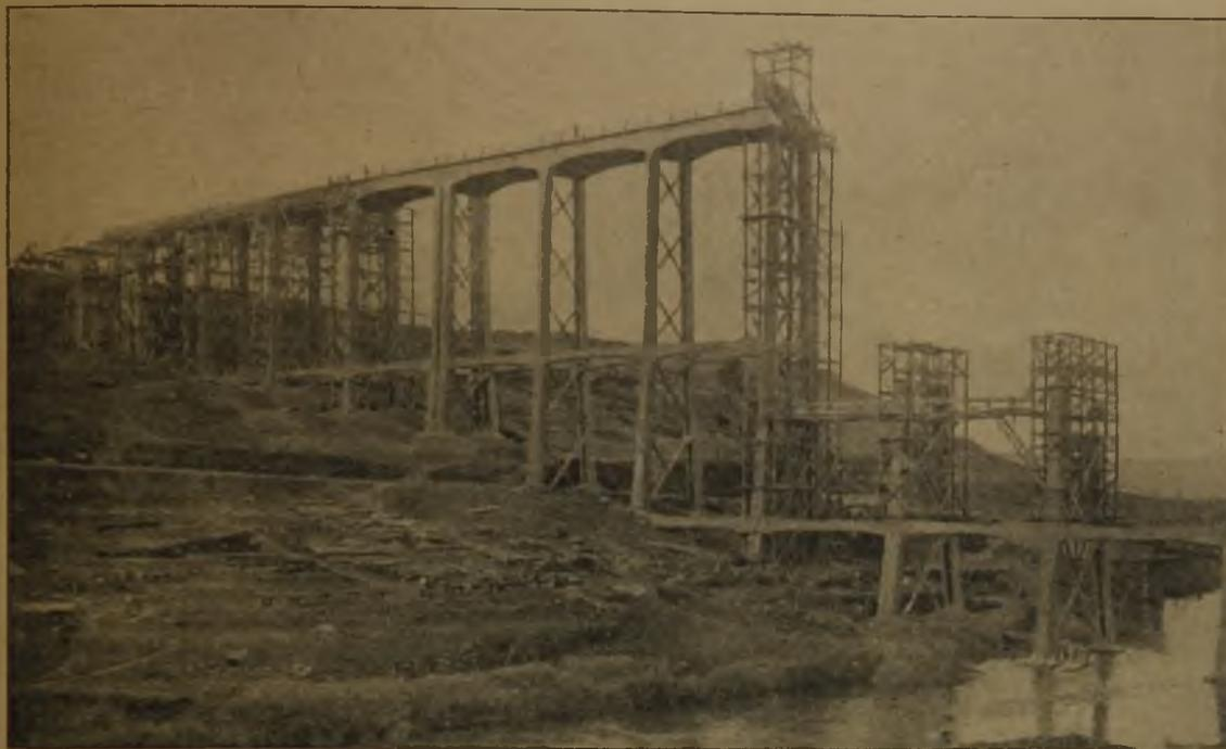
Abb. 6. Straßenbrücke von Tadasuni in Eisenbeton.
