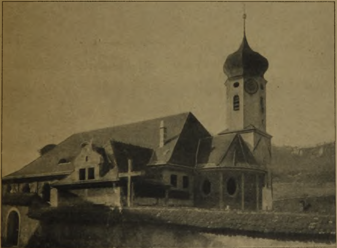
Abb. 2 Blick gegen den Chor. Erdbebensichere Kirche in Eisenbeton in Lautlingen (Schwäb. Alb).
