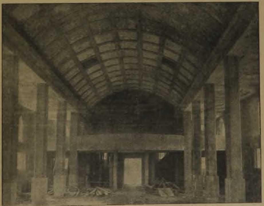
Abb. 6. Blick gegen die Orgelempore (Kirche im Rohbau).
