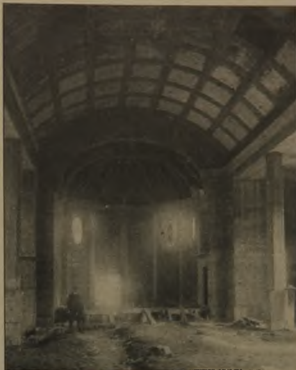
Abb. 7. Blick gegen den Chor (Robbau). Erdbebensichere Kirche in Eisenbeton in Lautlingen (Schwäb. Alb.).
