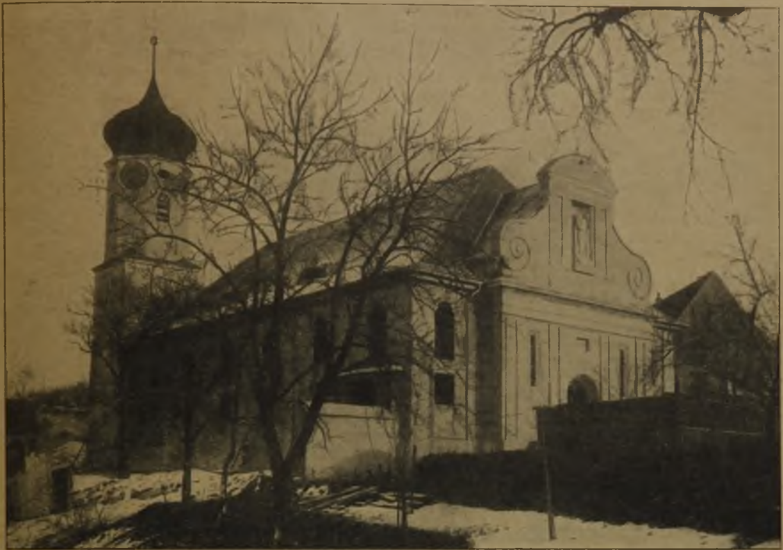
Abb. 1 Im Rohbau fertige Kirche. Blick gegen den Eingang.
