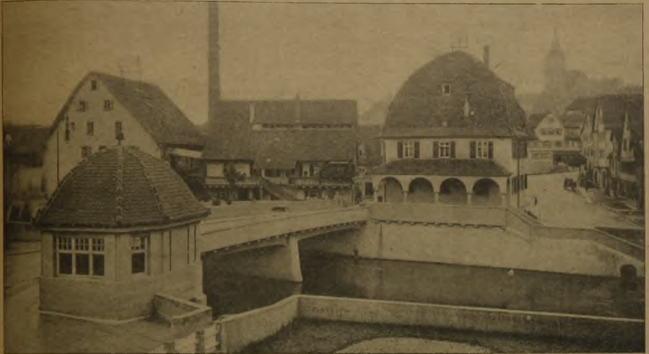
Abb. 5. Aaspacher Brücke über die Murr in Backnang. Erbaut 1911.
