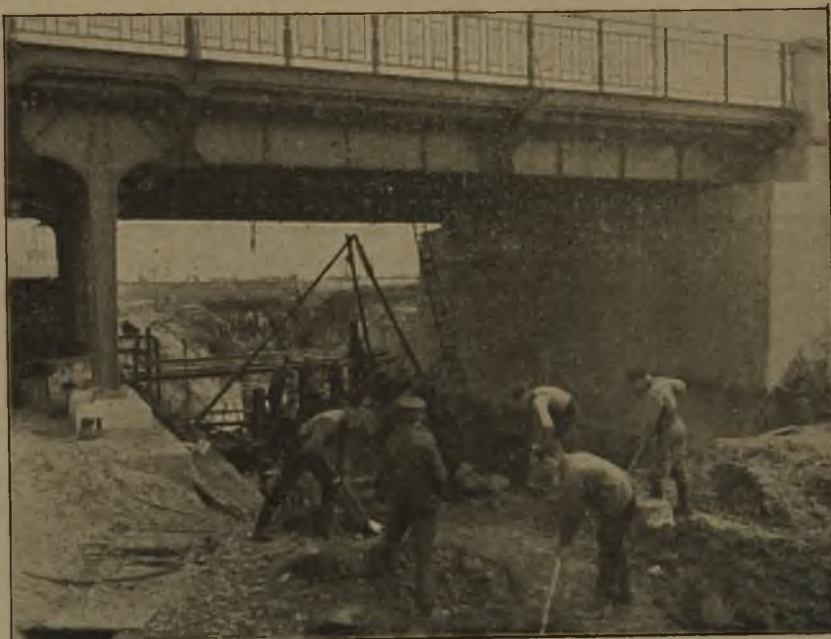
Abb. 9. Ausführung des Troges unter der Straßenbrücke.
