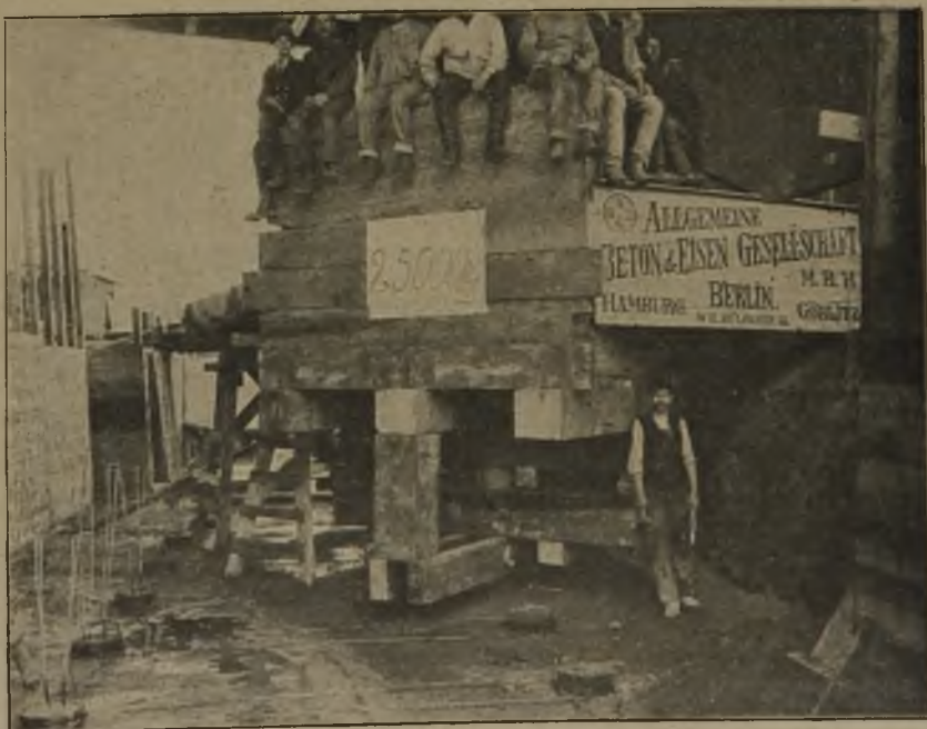
Abb. 10. Probelastung eines Beton-Bohr-Pfahles.
