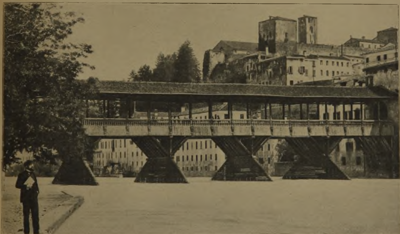
Ausgeführte Brenta-Brücke bei Bassano. Auf der Grundlage des Entwurfes von Andrea Palladio. Aus: Paul Zucker, Die Brücke. Typologie und Geschichte ihrer künstlerischen Gestaltung. Verlag von Ernst Wasmuth, A.-G. in Berlin.
