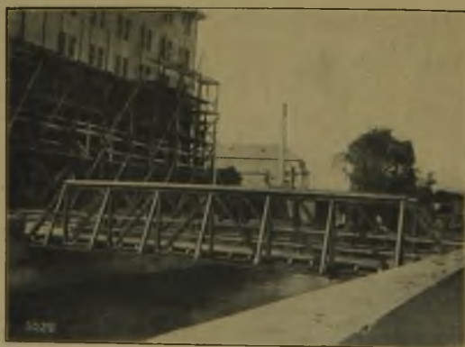
Abb. 1. Fußgängersteg in Wurzen in Sachsen. Freie Spannweite von 18 m. Ausführung der Christoph & Unmack A.-G. in Niesky in der O.-L.
