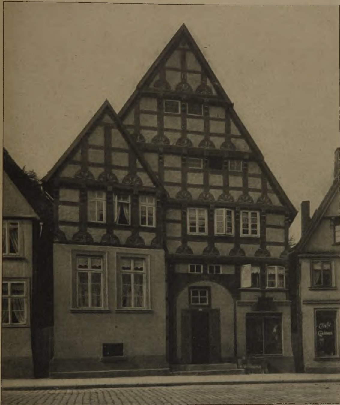
Fachwerkhaus Kreuz-Straße 43 in Bielefeld.
