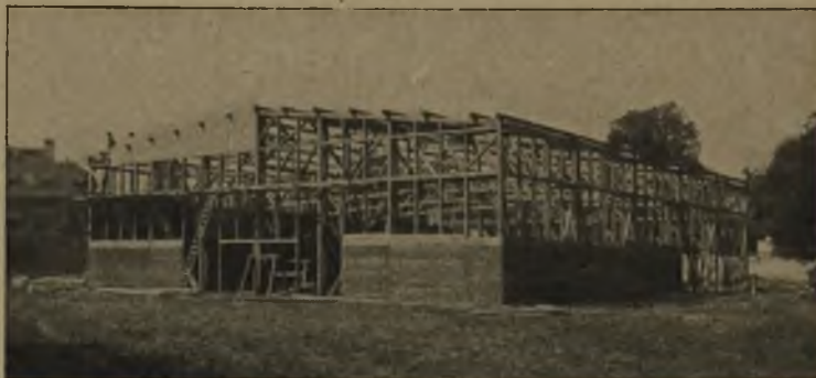
Abb. 6. Halle in der Ausführung.
