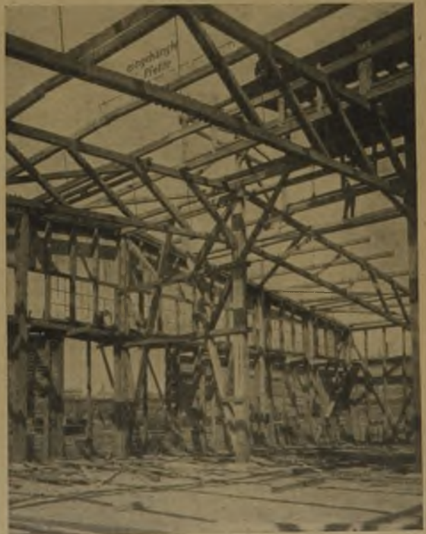
Abb. 8. Halle für Siedlung und Sozialfürsorge im Bau. Windportal, eingehangte Pfetten.
