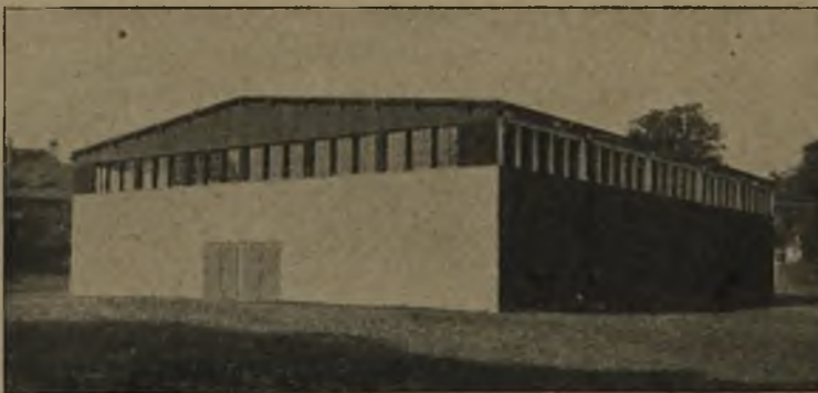
Abb. 7. Halle fertig verputzt.
