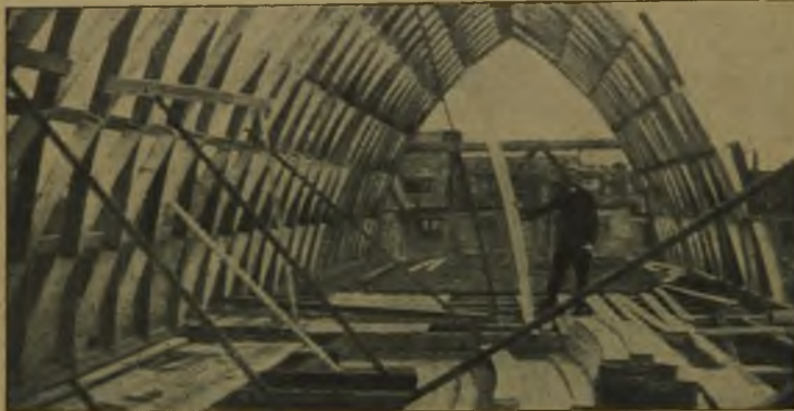
Abb. 11. Zollbau-Lamellen-Dach. Bogenform.
