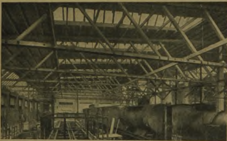
Inneres der Werkstätte der Simmeringer Waggonfabrik. 23 m Spannweite.
