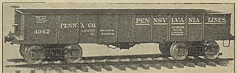
Figur 13. Offener Güterwagen der Pennsylvania-Bahn aus gepresstem Stahl.
