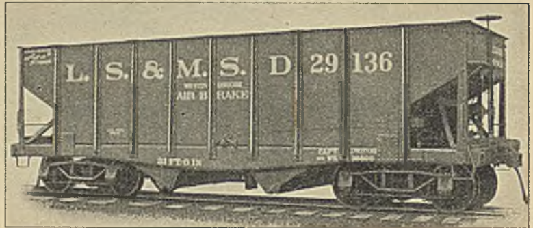
Figur 17. Kohlen- und Erzwagen der Lake Shore and Michigan Southern Bahn. Ladegewicht 45 400 kg.
