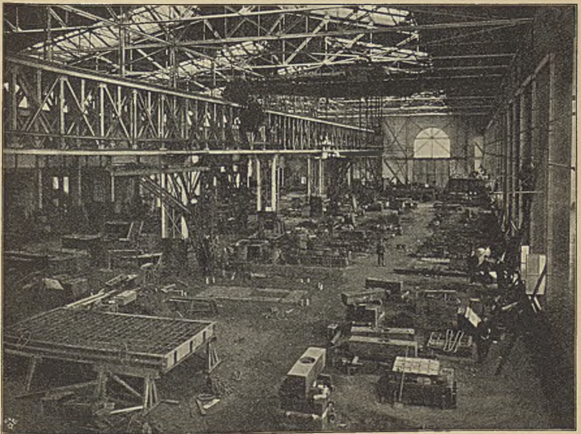
Figur 3. Innenansicht der Gießerei.
