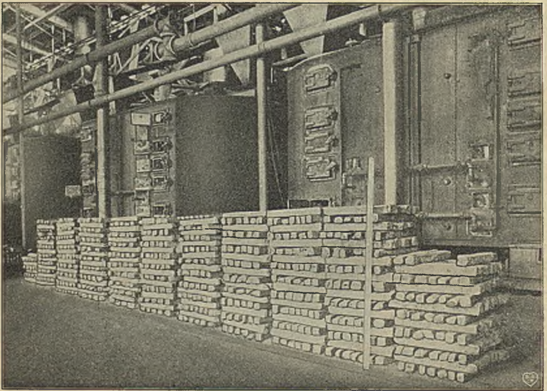
Abbildung 2. Roheisen im elektrischen Ofen hergestellt.
