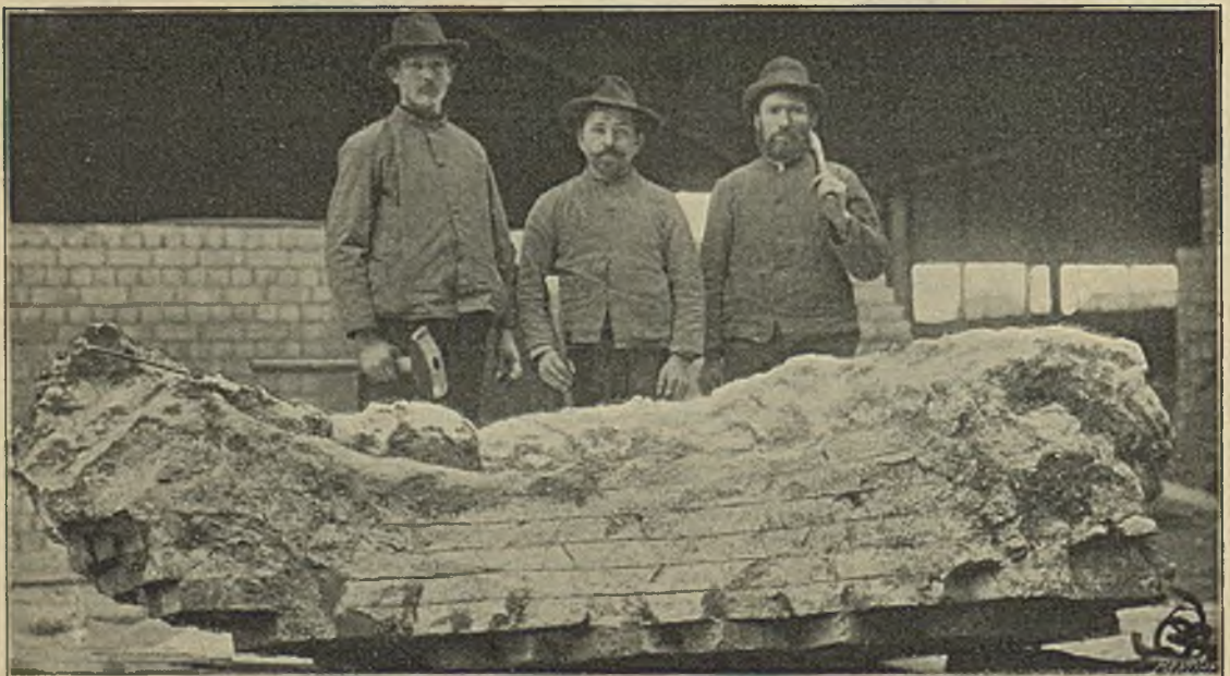
Abbildung 2. Der auseinandergesprengte Hochofenboden.
