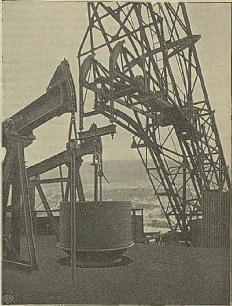
Abbildung 10. Förderkübel und oberer Teil des Schrägaufzuges.
