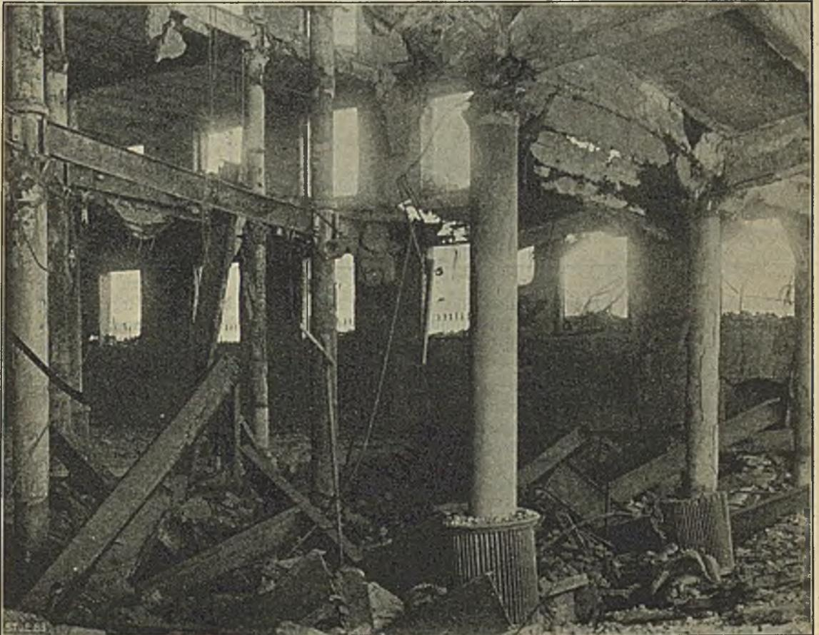
Abbildung 18. Gußeiserne, mit Terrakotta ummantelte Säulen.
