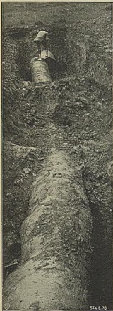
Abbildung 11. Wasserleitung durch Verwerfungsspalte zerstört.
