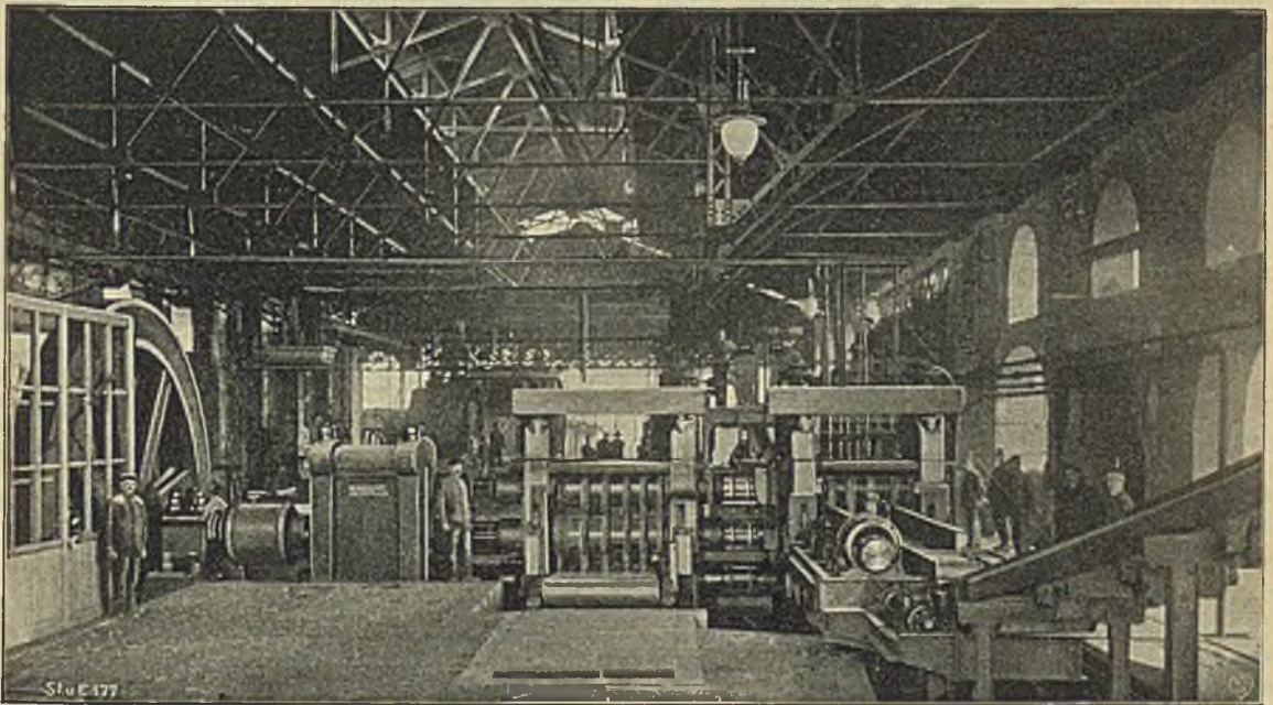
Abbildung 2. Rückwärtige Ansicht der Vorstrecke.
