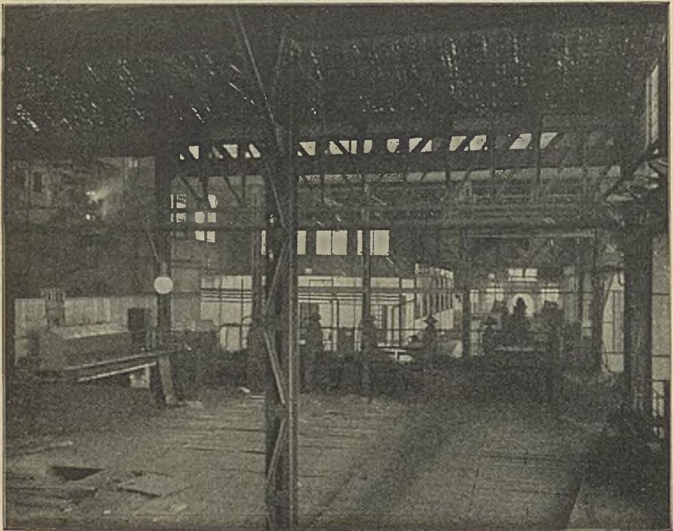
Abbildung 22. Einbau der Steuerschalter für die Rollgänge einer Triostraße der „Rheinischen Stahlwerke“.
