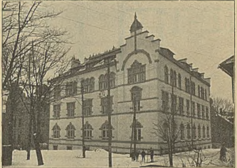
Abbildung 1. Das neue hüttenmännische Institut in Clausthal.
