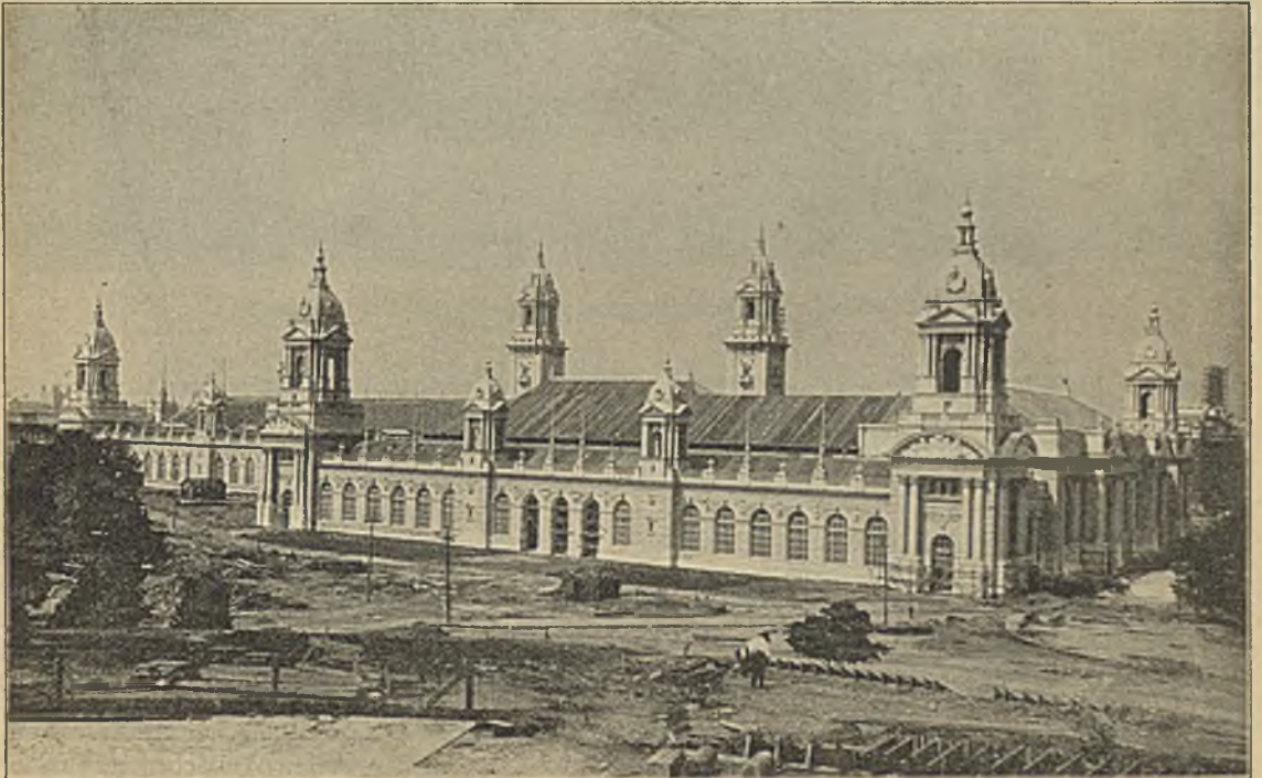
Abbildung 1. Gesamtansicht des Maschinengebäudes (von Süden gesehen).
