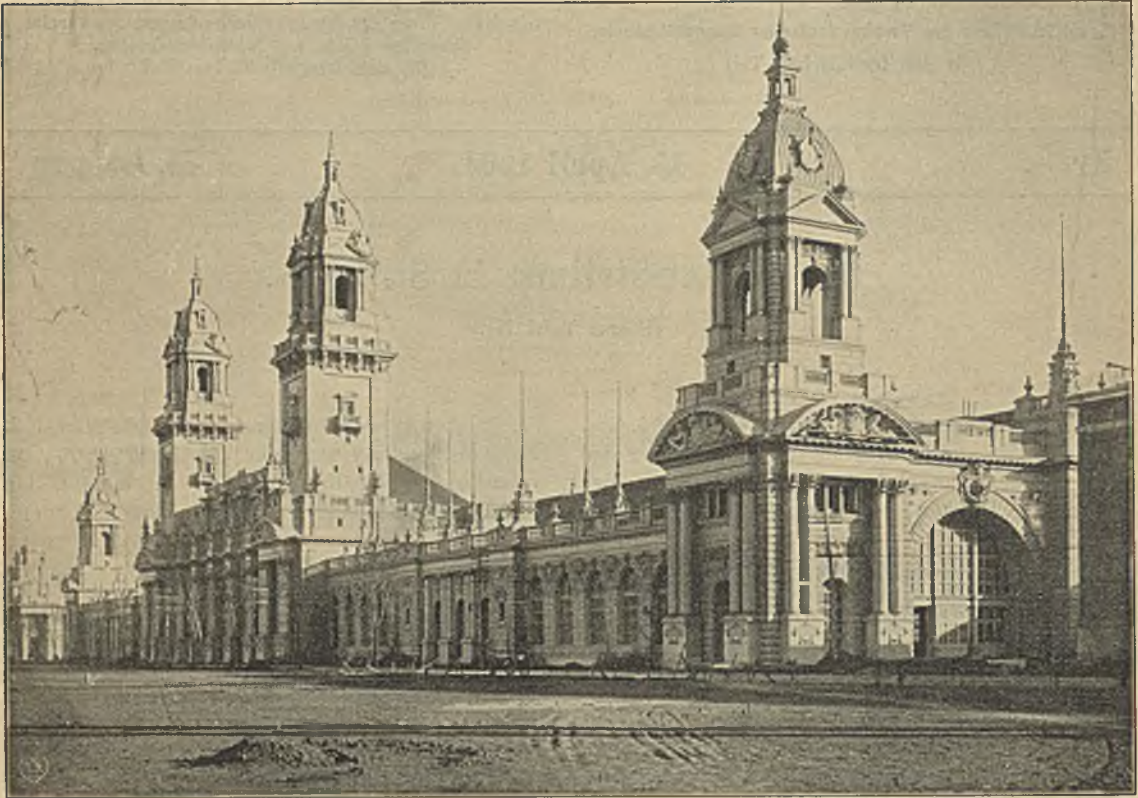
Abbildung 2. Vorderfront des Maschinengebäudes (von Norden gesehen).
