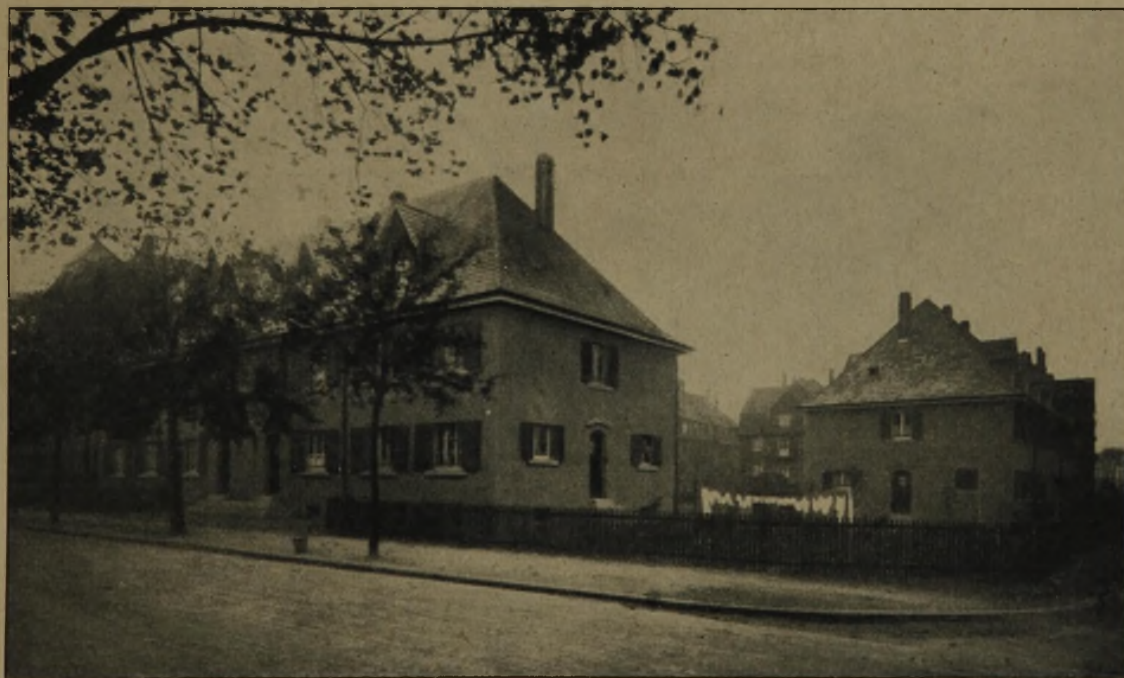
Abb. 7. Blick auf die Siedlung an der Tennenbacher Straße. Kleinhaus-Siedlung an der Bismarckstraße in Freiburg i. Br. Arch. Curt Balke, Freiburg i. Br.
