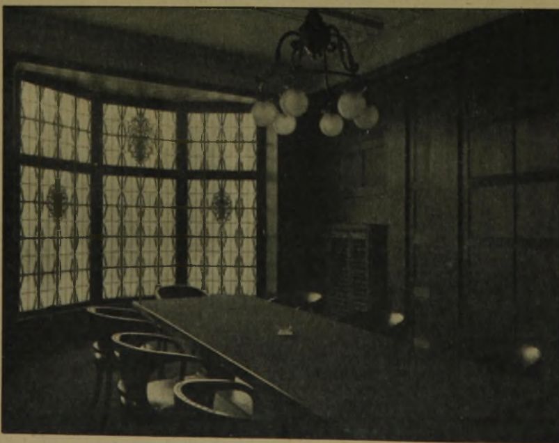
Abb. 9 (oben). Eingangshalle. Abb. 10. Sitzungssaal. Verwaltungsgebäude der Stanz- und Emallierwerke vorm. Carl Thiel & Söhne A.-G. in Lübeck.
