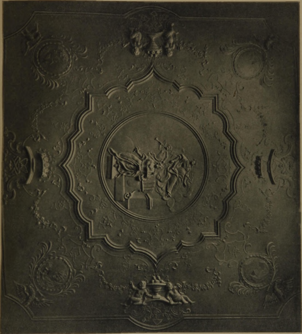
Abb. 3. Haus Kaiserstraße 79. Stuckdecke im II. Obergeschoß.
