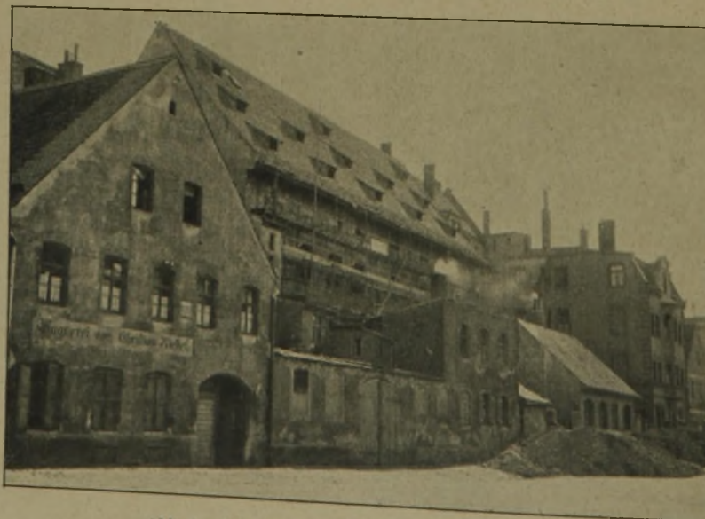
Abb. 4. Alter Zustand des Gebäudes.
