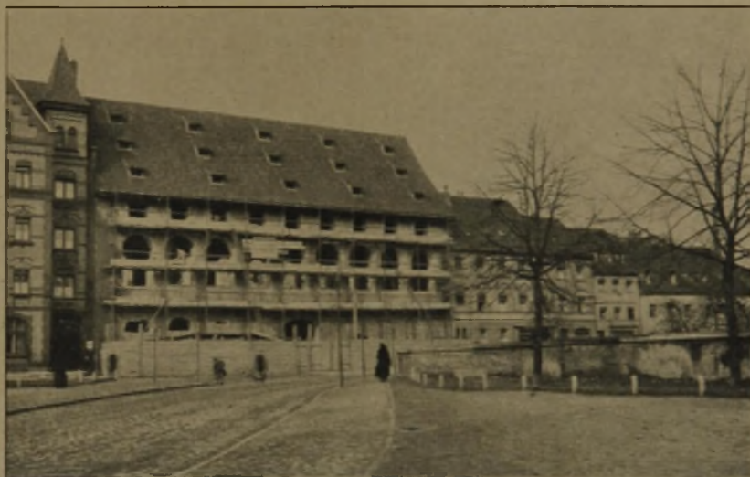
Abb. 6. Zustand nach Ausbruch der großen Rundbogen.
