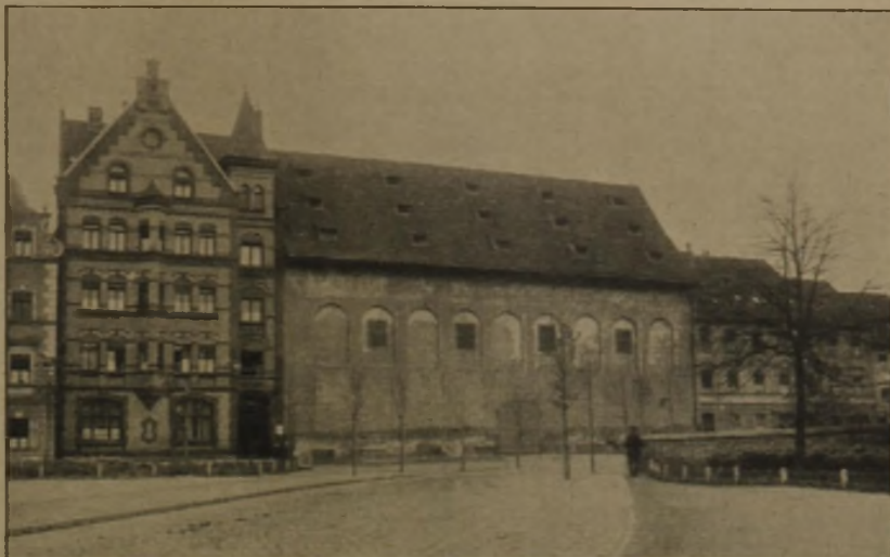
Abb. 5. Alter Zustand des Gebäudes (Straßenfront).
