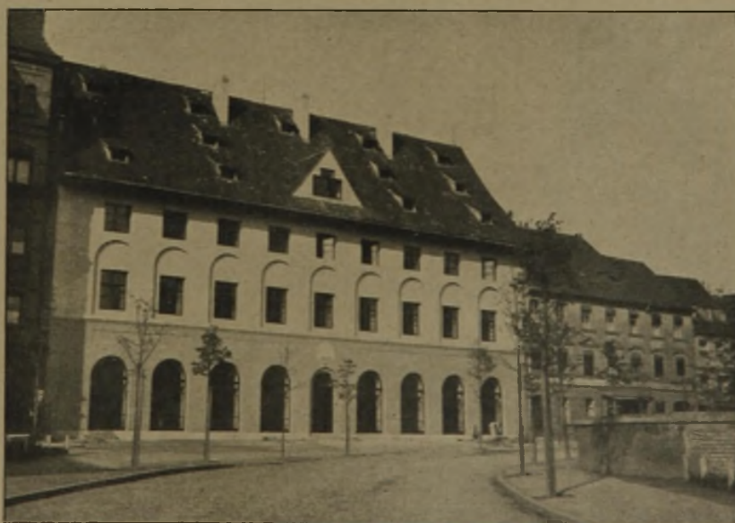
Abb. 7. Zustand des Gebäudes nach erfolgtem Umbau.
