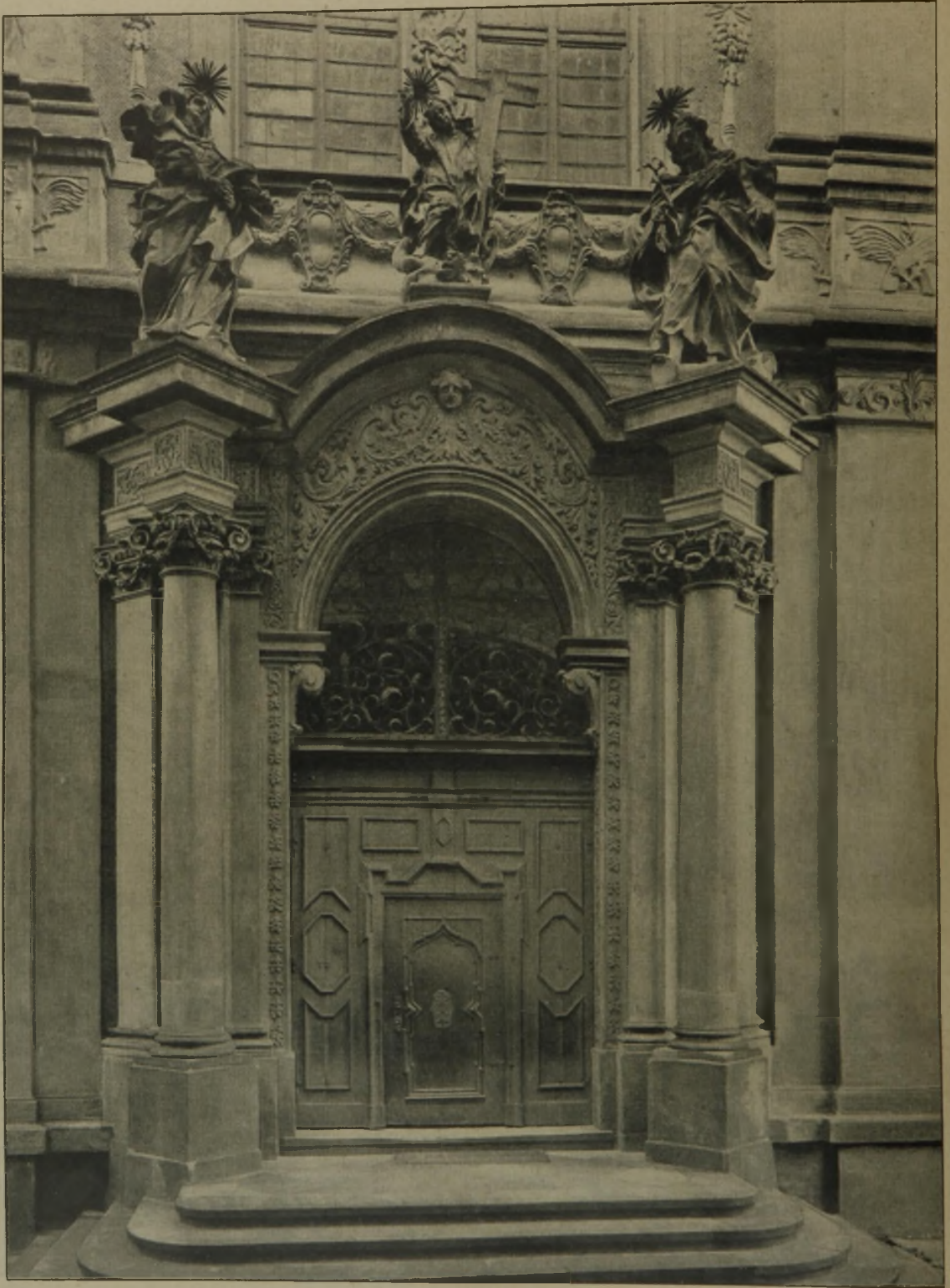
Abb. 8. Klosterkirche Lebus. Portal der Hauptfront. Nach einer Aufnahme der „Staatlichen Bildstelle“ in Berlin.
