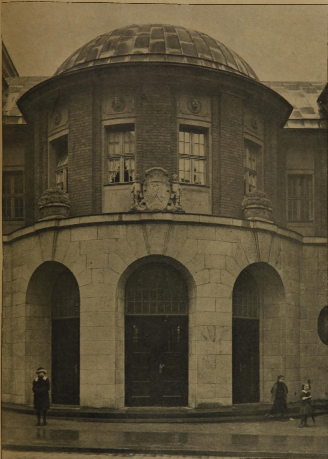
Abb. 5. Zwischenbau zwischen Alt- und Neubau mit Eingang für die Gesamtanlage. Städt. Hochbauten in Essen-Ruhr. III. Erweiterung der Badeanstalt a. d. Steeler Straße.
