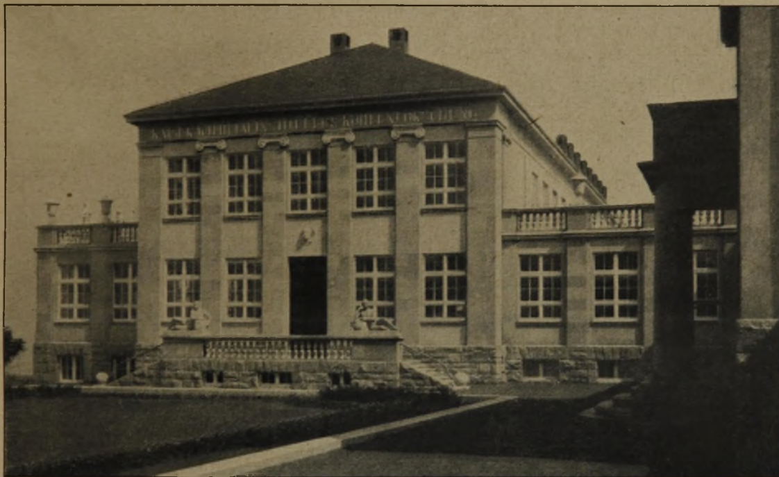
Abb. 5. Ansicht des Hauptgebäudes gegen den Schmuckplatz mit Verbindung zum Direktor-Wohnhaus.
