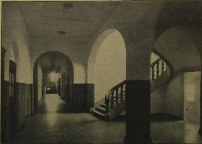
Abb. 6. Blick in Treppenhaus und Korridor.
