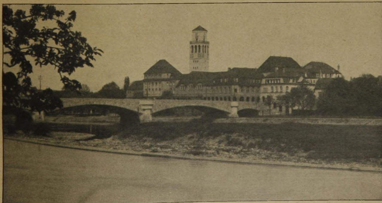
Abb. 11. Schloßbrücke mit Blick auf Stadtbad und Brückenwärterhaus (dahinter Rathausurm).
