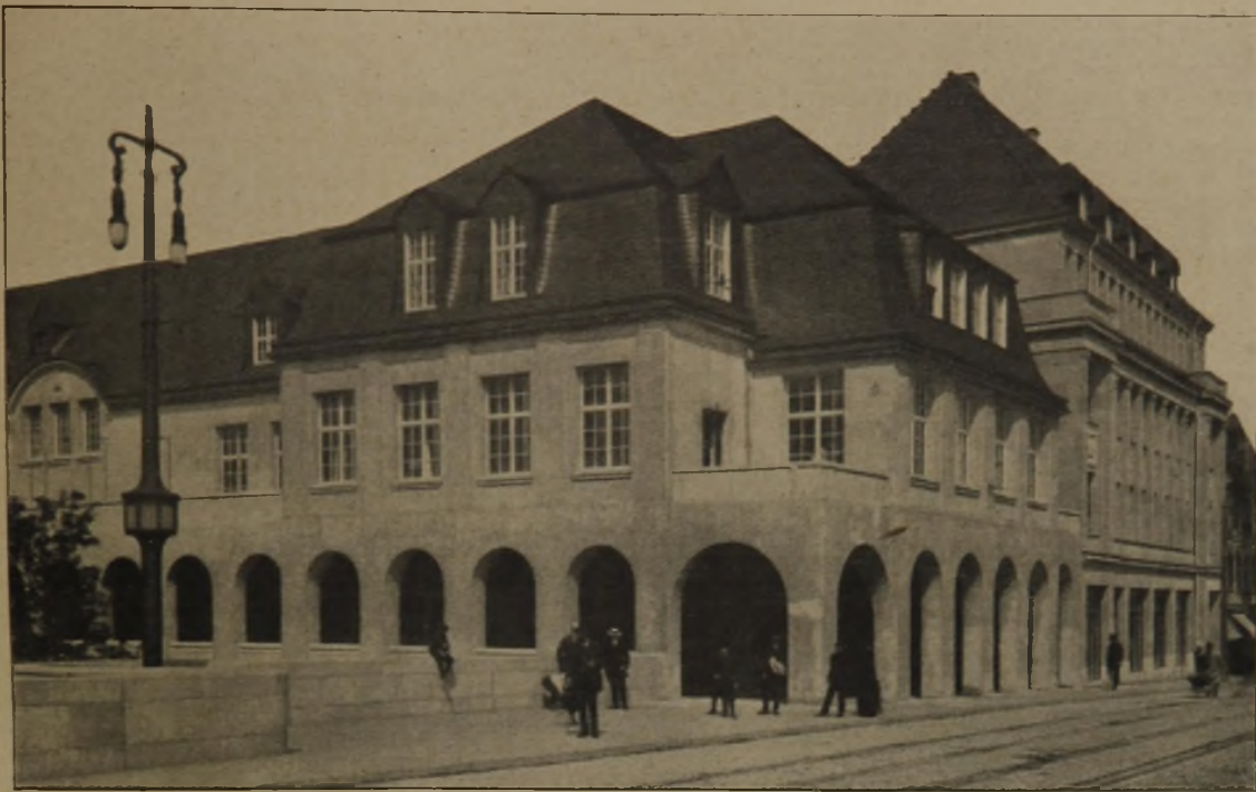
Abb. 13. Ansicht des Stadtbades am Zusammenschnitt mit der Ruhrbrücke.
