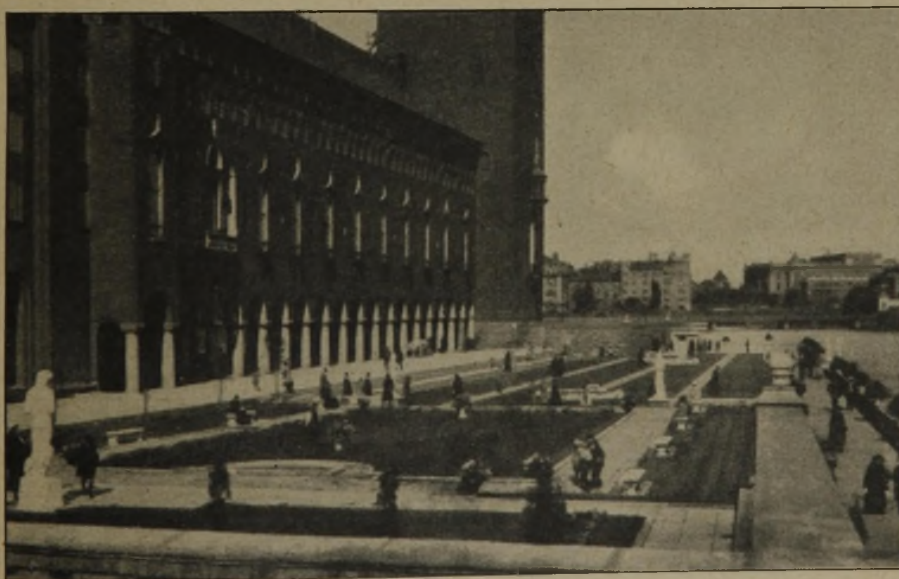
Abb. 12 Fassade nach dem Mälarsee und Gartenterrasse.
