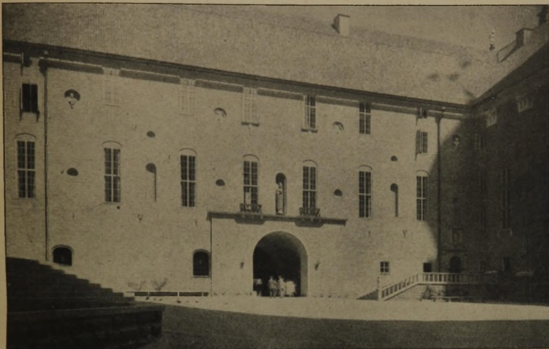
Abb. 11. Südfassade des Bürgerhofes.
