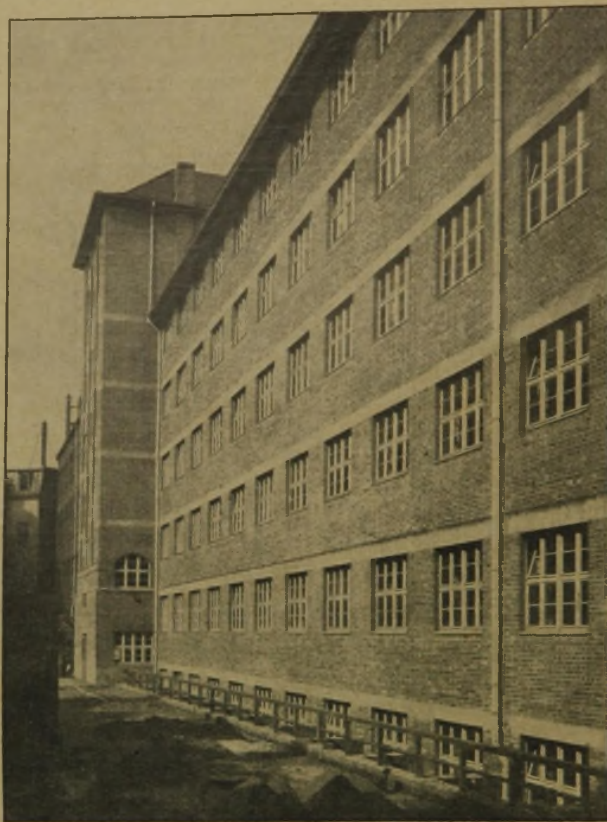
Abb. 2. Hoffassade des Messehauses in rotem Backstein mit Betonbändern.
