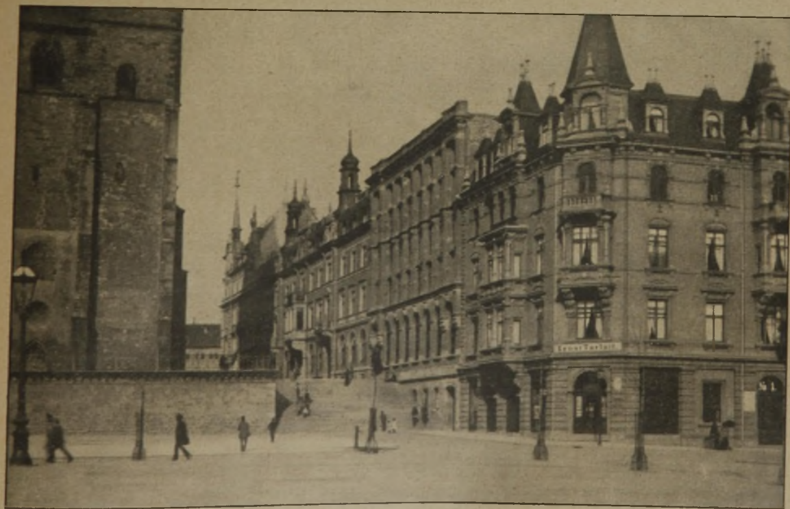
Abb. 12. Teilansicht des Kirchenfußes vor Erbauung des Umformerwerkes.
