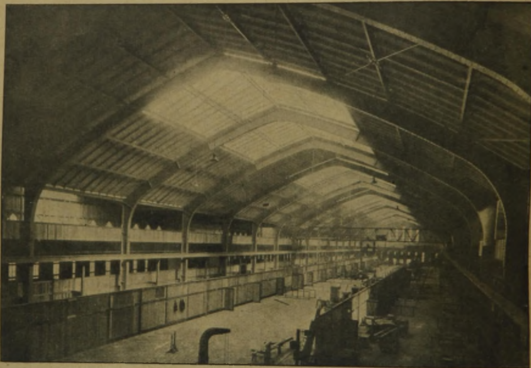
Abb. 1. Blick in das „Haus der Technik“. Hallenbau der Masch.-Fabrik Augsburg-Nürnberg, Werk Gustavsburg b. Mainz. Bauten der Frankfurter Messe.
