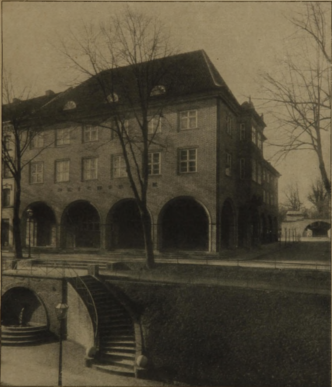
Abb. 18. Geschäftsgebäude der Reichsbankstelle in Schwerin i. M. Arch.: Reg.-Baumeister Franz Kassbaum.
