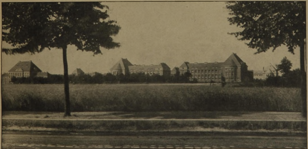
Abb. 1. Gesamtansicht der Institute vom Windmühlenweg aus.
