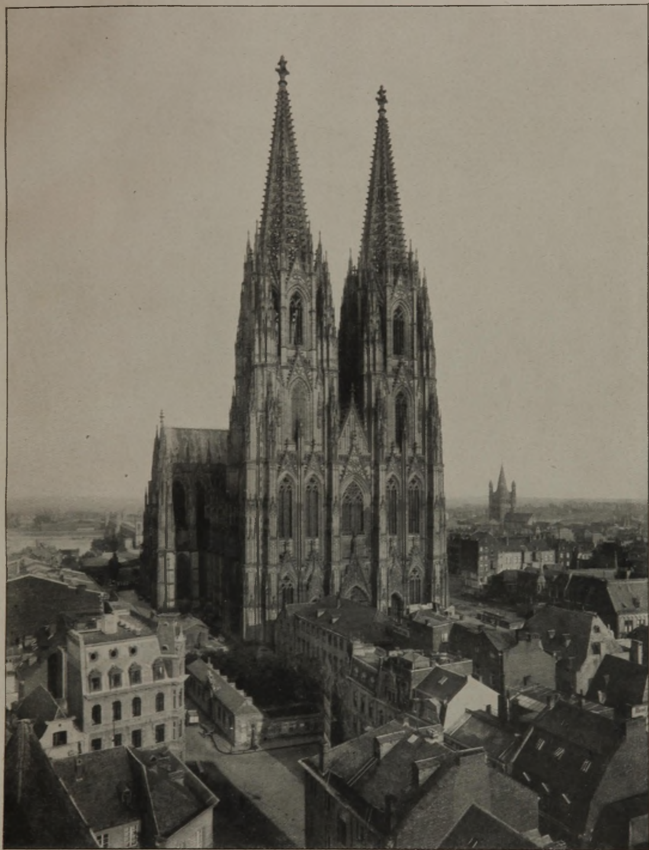
DIE UMGESTALTUNG DER UMGEBUNG DES DOMES IN KÖLN AUFNAHME DER WESTSEITE AUS DER ERSTEN HALFTE DER ACHTZIGER JAHRE V. JAHRH. VOR DER FREILEGUNG DEUTSCHE BAUZEITUNG. LVIII. JAHRGANG 1924. NR. 88
