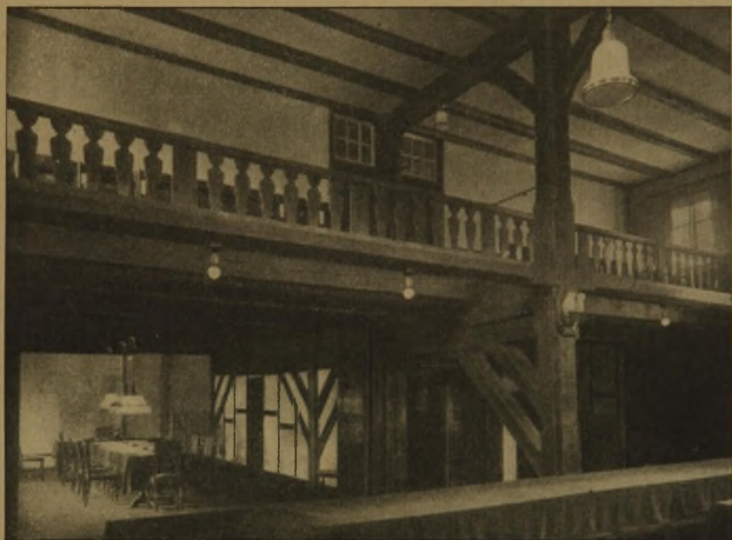
Abb. 10. Einblick in den Kreistagsaal und den nach Westen anstoßenden Kreisausschußaal. (Die alte Unterzugkonstruktion ist beibehalten.)
