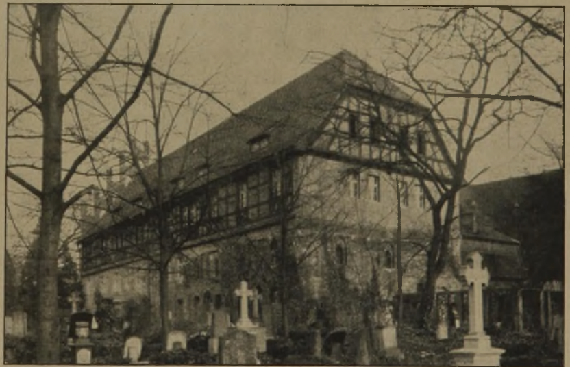
Abb. 6. Ansicht des Klosterbaues von Nordwesten nach dem Umbau.
