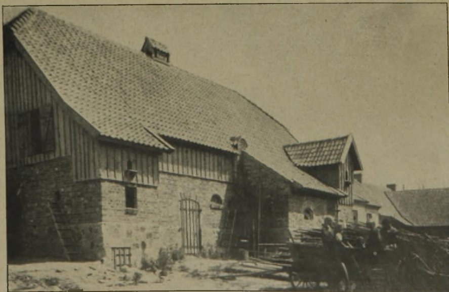
Abb. 20. Hofansicht eines zusammengebauten Gehöftes.
