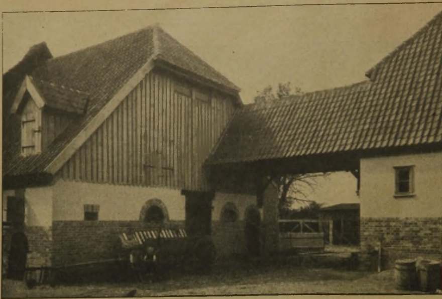
Abb. 12. Blick vom Hof auf Wohngebäude u. Stall m. Verb.-Gang. (Zu Abb. 9—11.)
