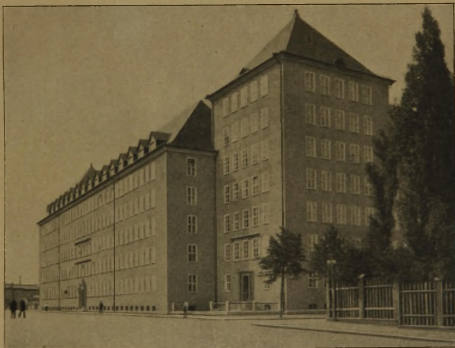
Abb. 10. Hauptfront an der Arnulfstraße mit Turm an der Ecke der Spatenstraße.
