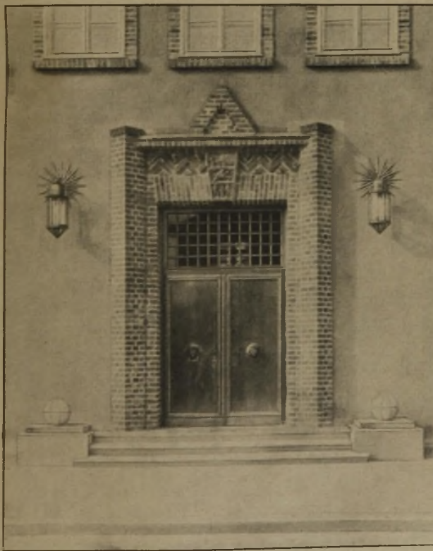
Abb. 13. Haupteingang an der Arnulfstraße. Neubau eines Post-, Telegraphen- und Fernsprechdienstgebäudes in München.
