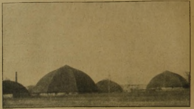
Abb. 3. Solbehälter der Saline Wilhelmshall in Württemberg.
