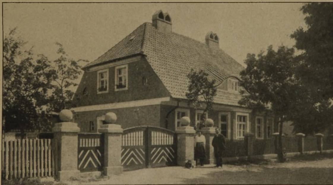
Abb. 18. Wohnhaus Karl Krüger in Prostken, Kreis Lyck. (Grundriß Abb. 5). Wiederaufbau-Arbeiten im Kreise Lyck, Ostrp.
