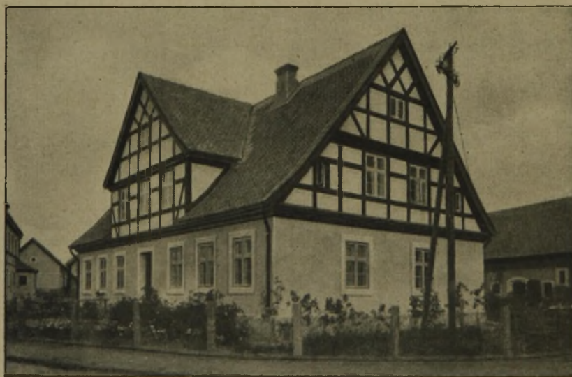
Abb. 16. Wohn- und Gasthaus Lassarig. (Grundriß Abb. 11.) Häuser aus Borszymmen, Kr. Lyck. Wiederaufbau-Arbeiten im Kreise Lyck, Ostpr.
