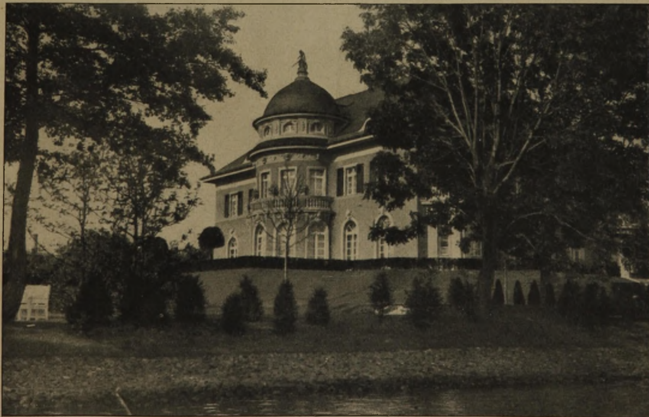
Abb. 6. Blick auf die rückseitige Gartenfront mit Terrassenanlagen.
