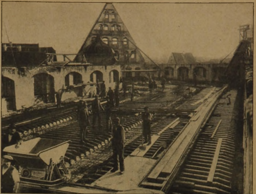
Abb. 3. Zwischendecke aus Eisenbeton.
