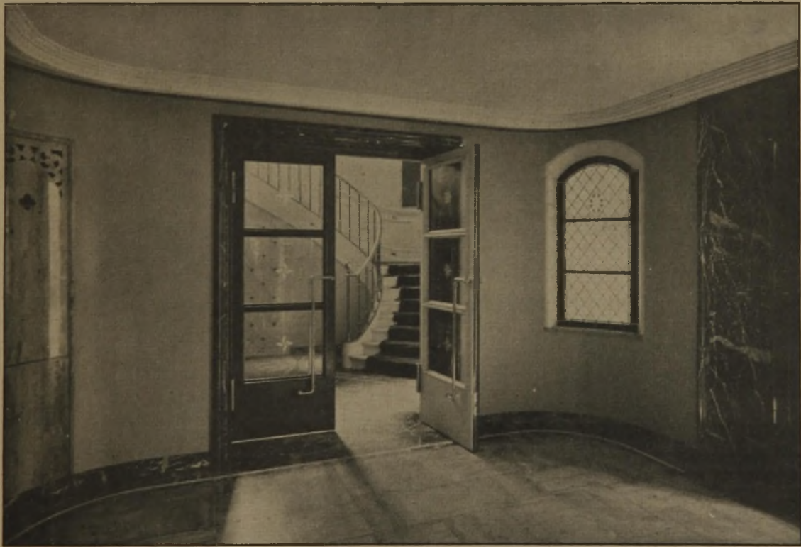
Abb. 18. Blick vom Vestibül gegen die Treppe zum Hauptgeschoß. (Marmorbelag deutsch-gelb mit schwarzem Fries. Heizkörperbekleidung deutsch-gelb. Decke grün. Türen, Eiche gebeizt, mit Bronze-Beschlägen.)
