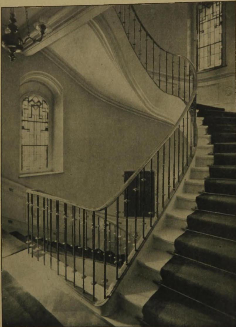
Abb. 19. Haupttreppenhaus. (Stufen u. Wandpaneel weiß Schleiflack. Teppich grün. Geländer Eisen mit gedrückten Messingprofilen. Abschlußschiene und Handlauf Bronze. Farbige Glasfenster, Entwurf Franz Mutzenbecher.)
