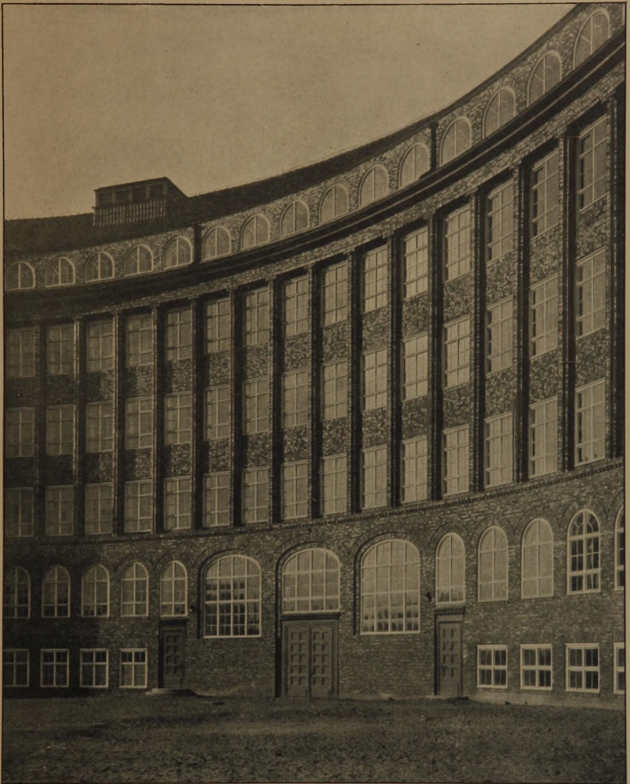
Abb. 8. Fassadenteil nach dem Spielplatz.
