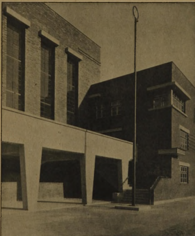
Abb. 9. Teilansicht des Kopfbauers. Das Haus der Technik in Königsberg i. Pr.
