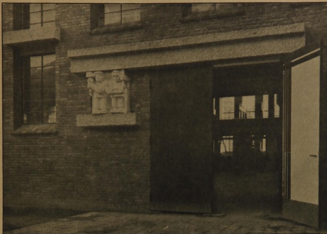
Abb. 8. Tür der Durchfahrt.
