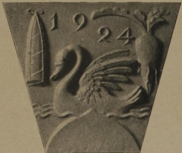
Abb. 6. Wappen der Stadt Prenzlau usw. über Haustür der Abb. 4. Beton-Werkstein.
