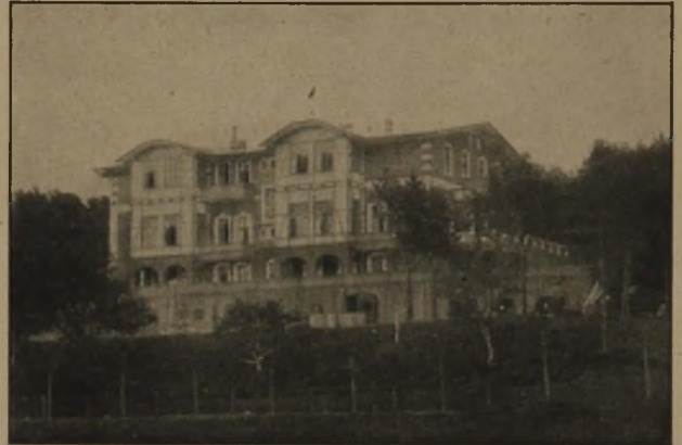
Abb. 10. Nordwestansicht vor dem Umbau.
