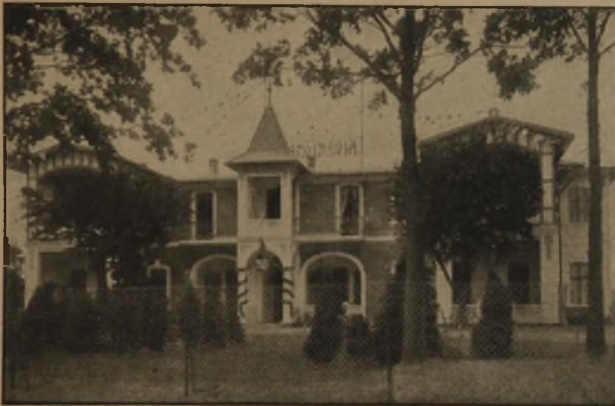
Abb. 9. Südostansicht vor dem Umbau.
