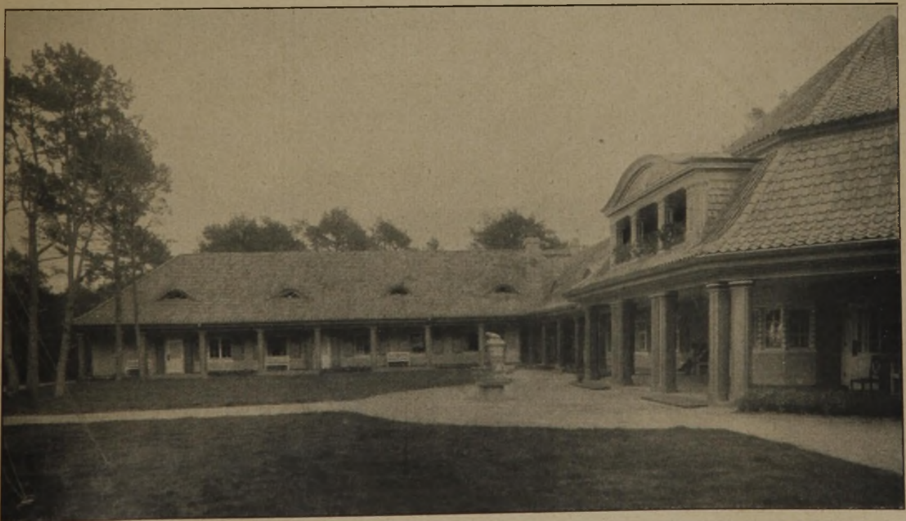
Abb. 1. Linker Seitenflügel der Nordseite mit Brunnen.
