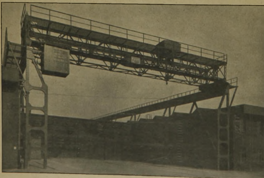
Abb. 14 (oben). Materialhof mit Krananlage.
