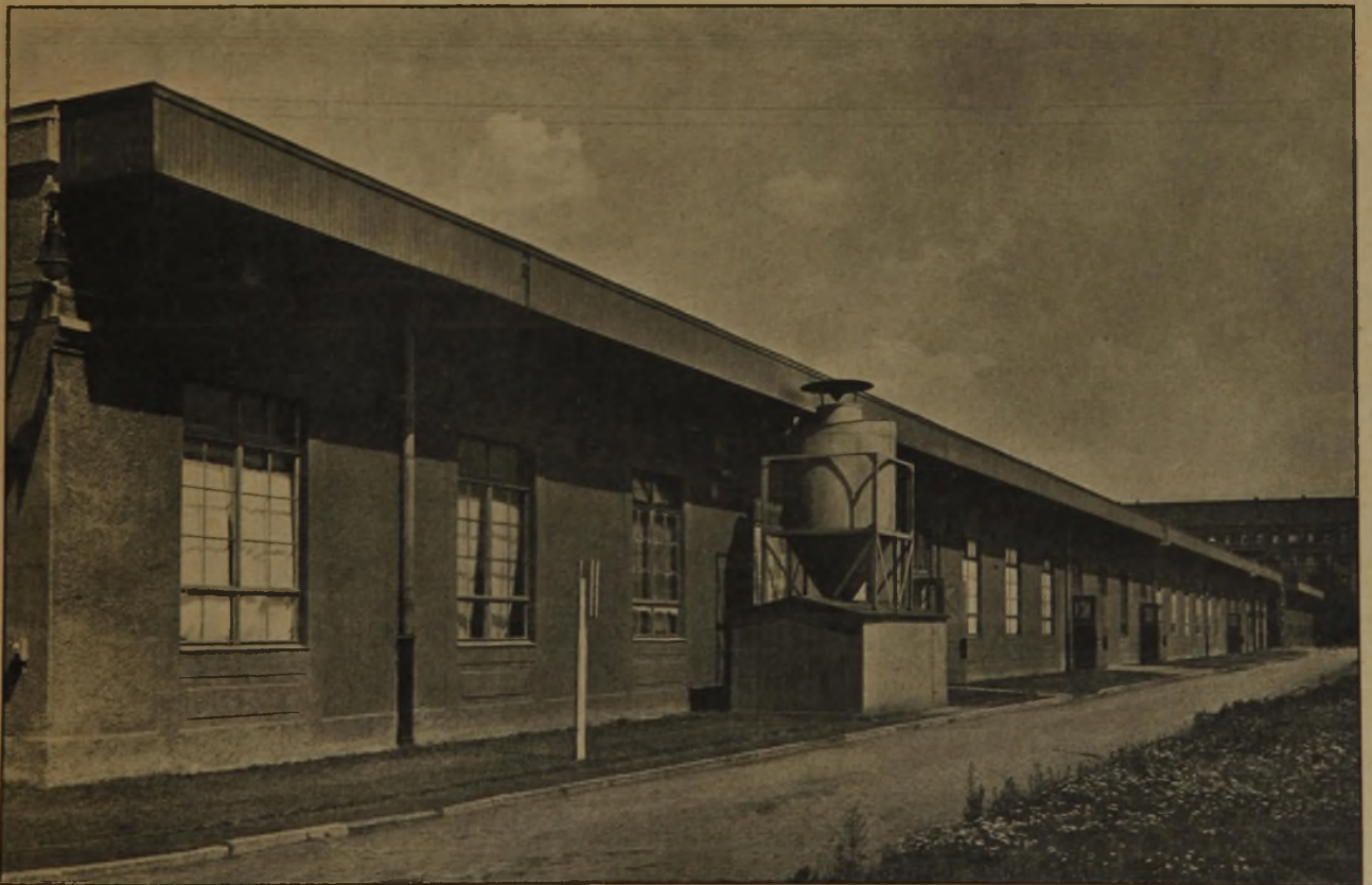
Abb. 4. Südfassade des „Schaltwerkes“.
