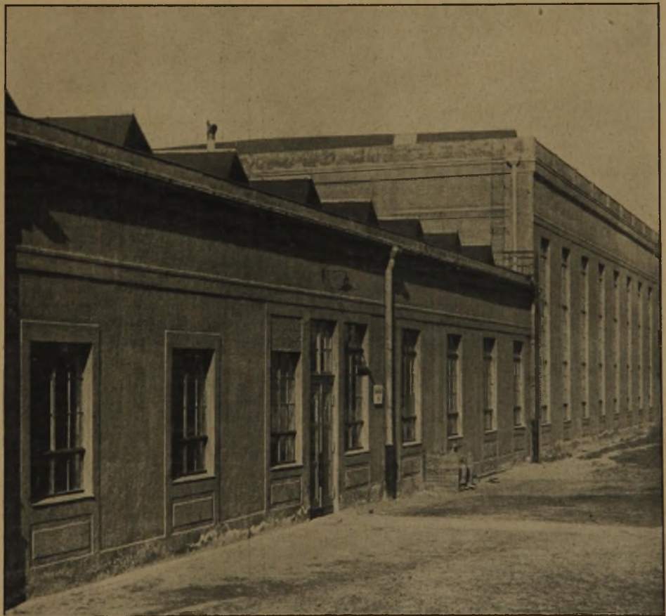
Abb. 17 u. 18. Teilansichten der Ostfassade.
