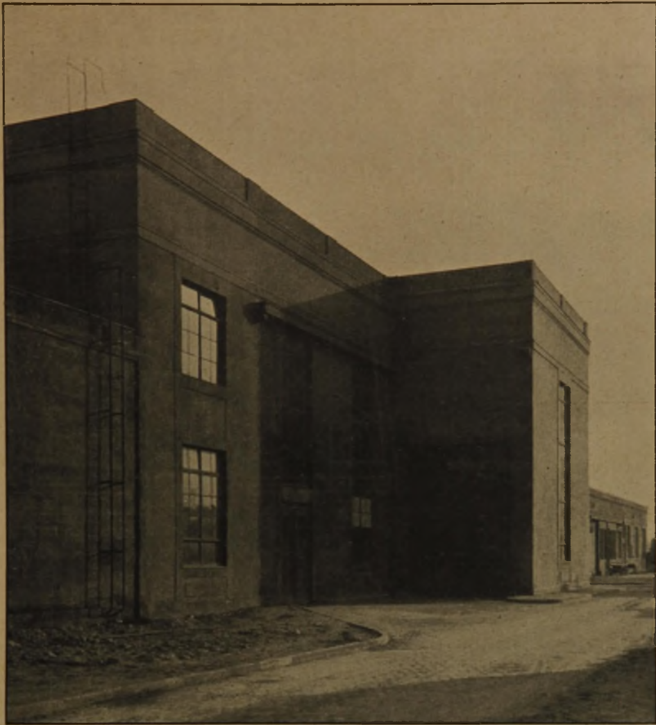
Abb. 3. Teilansicht der Ostfassade.
