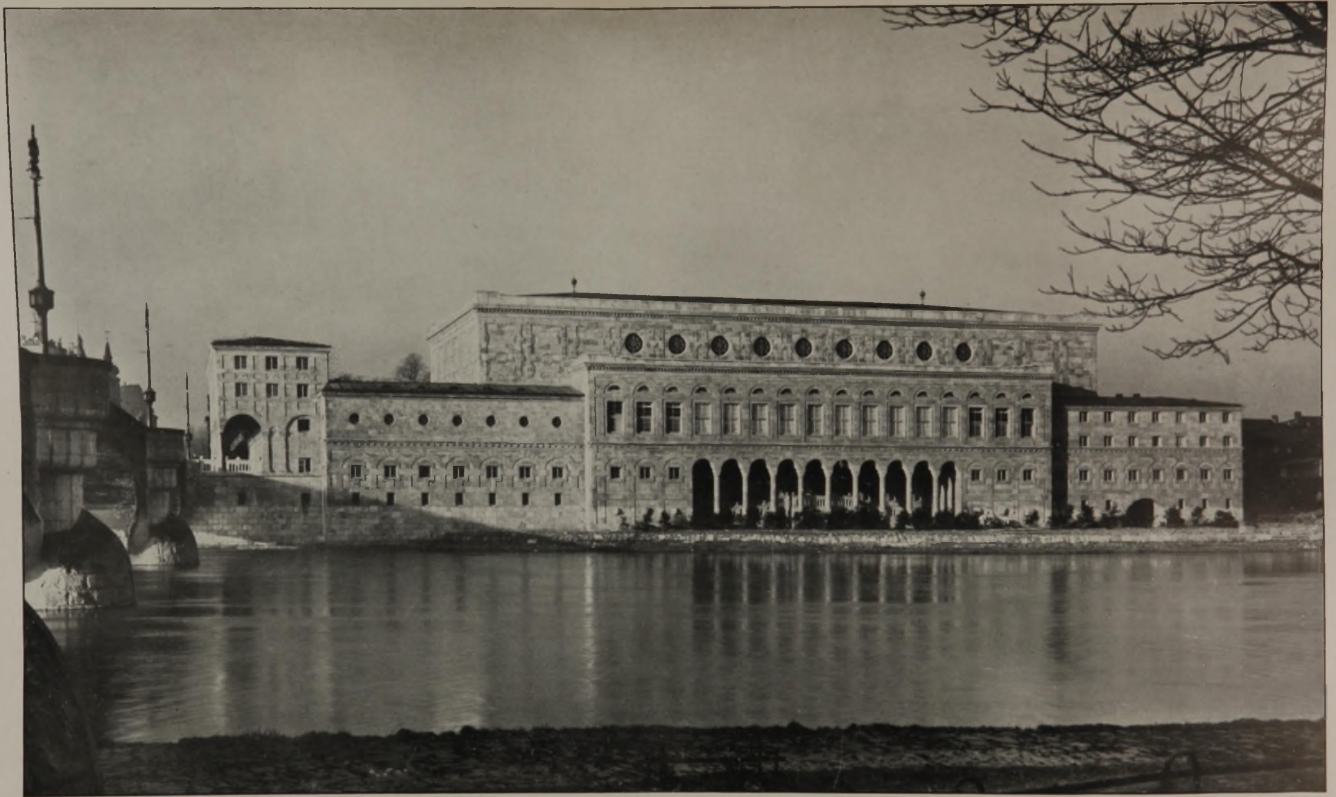
STADTHALLE IN MÜLHEIM-RUHR / ANSICHT VON DER RUHRSEITE MIT SCHLOSSBRÜCKE ARCHITEKTEN: PFEIFER UND GROSSMANN IN MÜLHEIM-RUHR DEUTSCHE BAUZEITUNG. LX. JAHRGANG 1926. NR. 16/17
